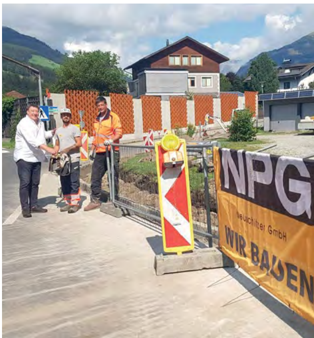
Bgm. Josef Jury auf „Bauaufsicht“
